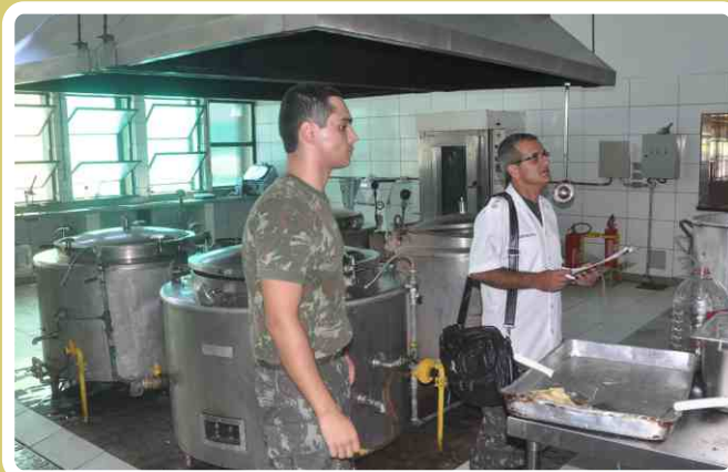
Verificação dos equipamentos da cozinha
