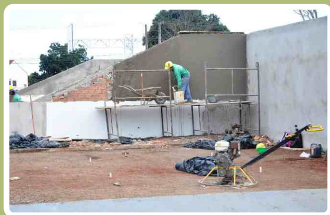
Reconstrução das quadras poliesportivas
