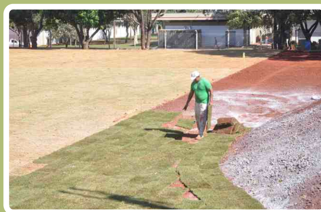
Construção da área de lazer do CFS
