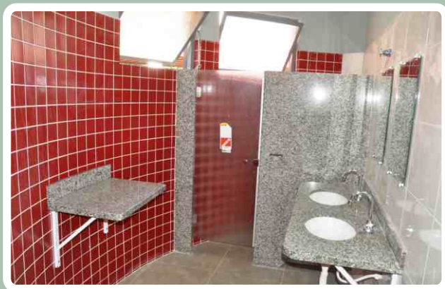
Reforma do banheiro do refeitório dos ST/Sgt
