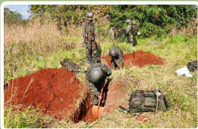
Construção de abrigo individual
