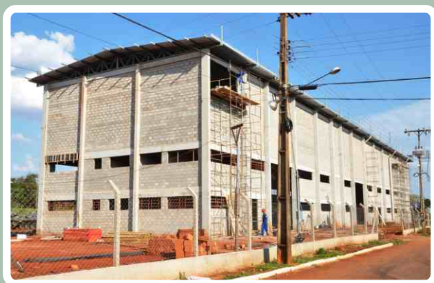
Construção do pavilhão de manutenção
